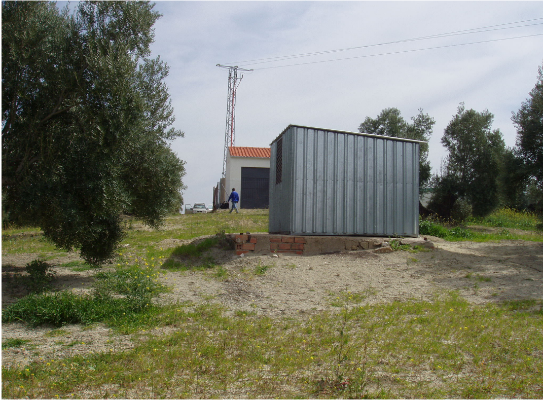
(19) Sondeo El Cortjuelo (C.R. El Fontarrón). Vista general, con caseta sondeo en primer plano
