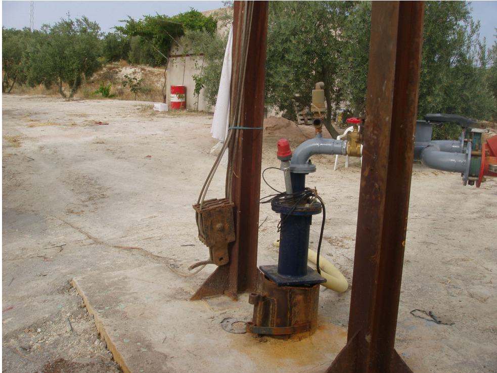
(61) Sondeo de propietario desconocido (detalle)
